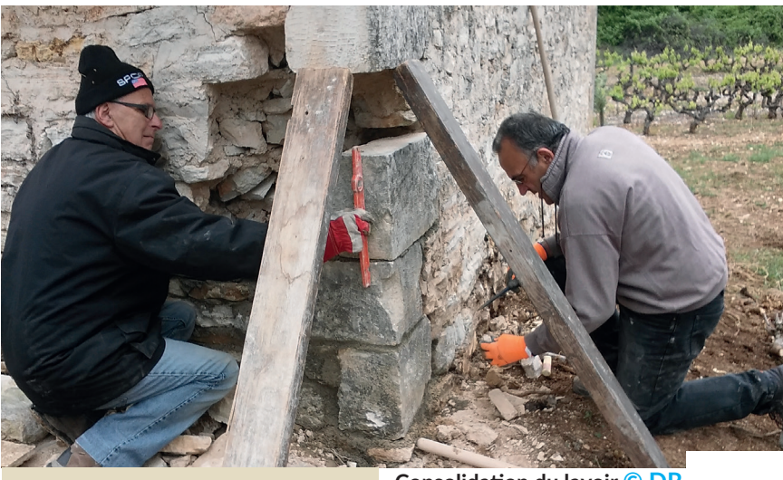
Consolidation du lavoir © DR
